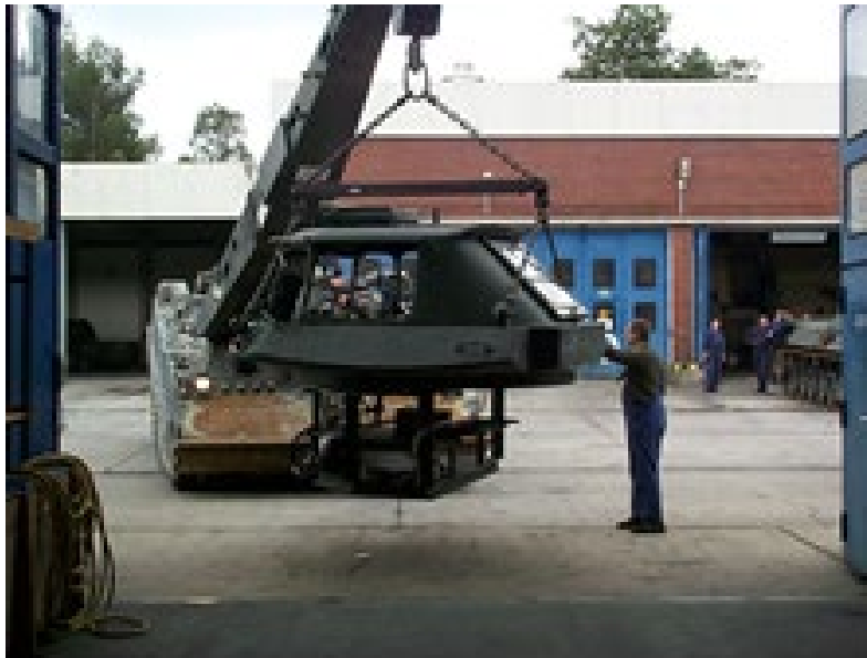
Wartungsarbeiten an der Fahrschulkabine Leo 1
